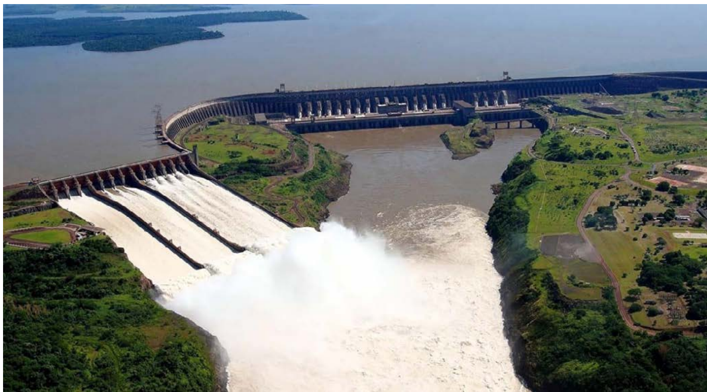
Figura 27. Itaipú Binacional, central generadora de energía eléctrica 93 .
