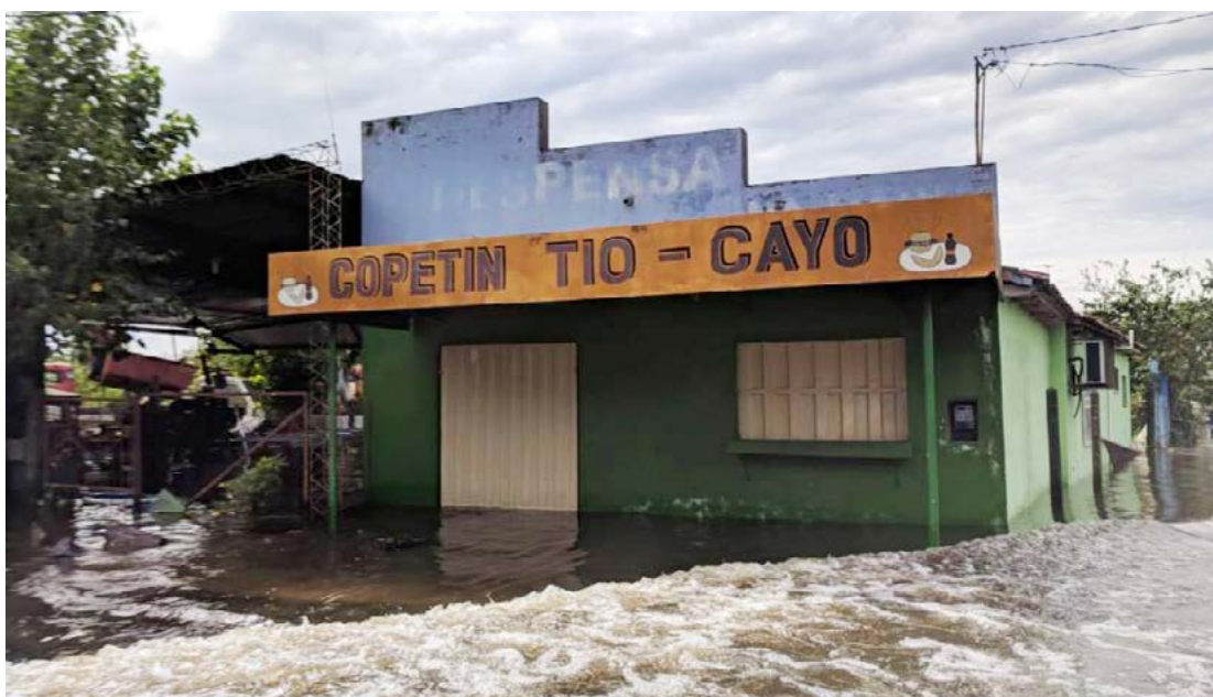
Figura 22. Calles inundadas en Pilar, Ñeembucú, afectada por la lluvia histórica en mayo 2019 76 .
